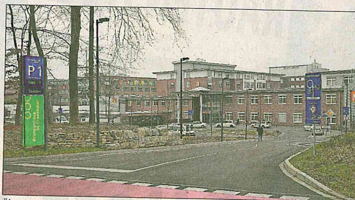
Übersichtlich und in Modulbauweise schlau angeordnet sind die Gebäude des Krankenhauses St. Franziskus. Im Herbst sollen weitere Erweiterungsbauten dazu kommen. Fotos: Andreas Baum
